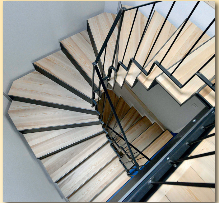
Treppe Holz Metall
