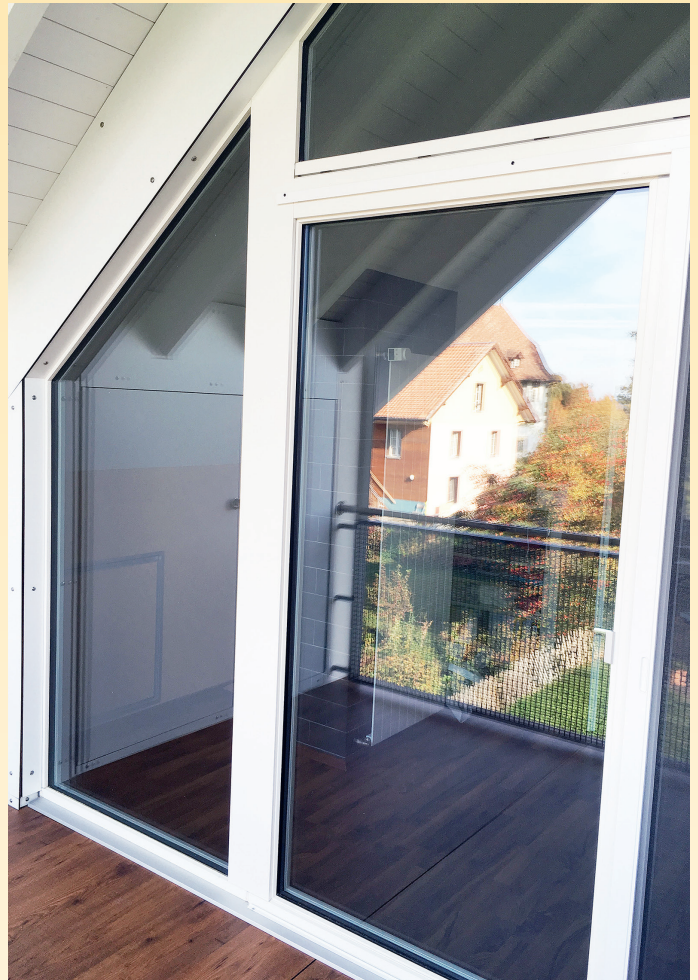
Fenster in Dachschräge
